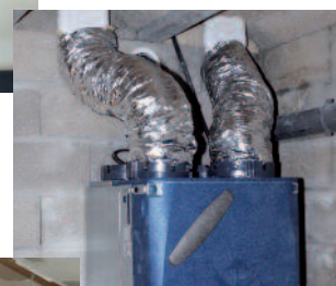
Montage chaudière en cellier
