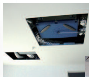
Montage dissocié en faux plafond
