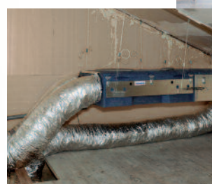
Montage assemblé en combles
